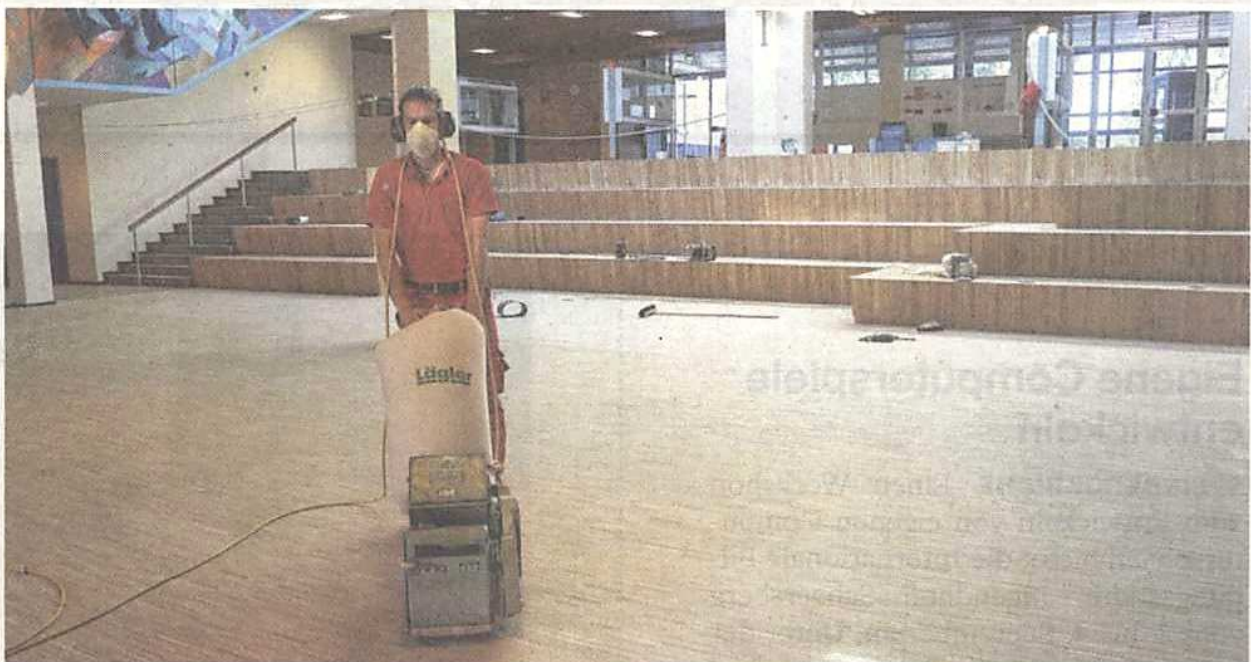
In der Aula der Auenwaldschule erhält das neue Parkett den letzten Schliff.
